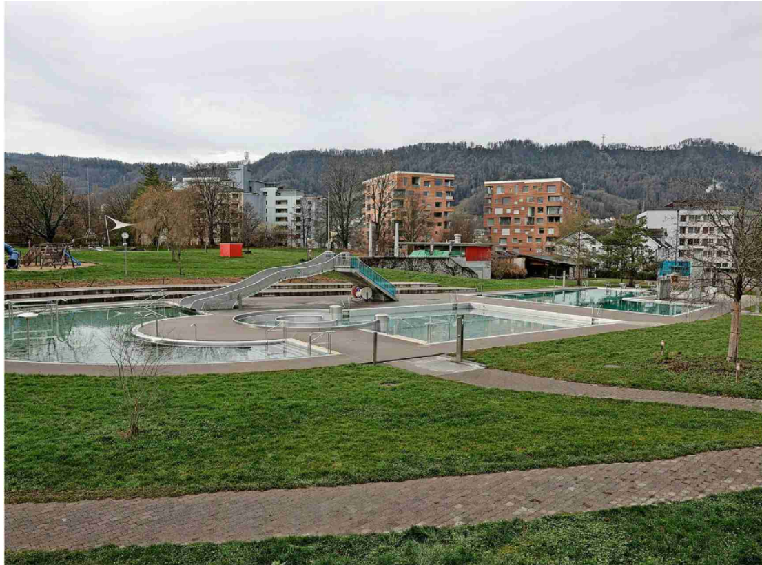
Das Freibad Adliswil wurde 2004 letztmals umfassend saniert. Nun sind Massnahmen nötig. Foto: Moritz Hager
